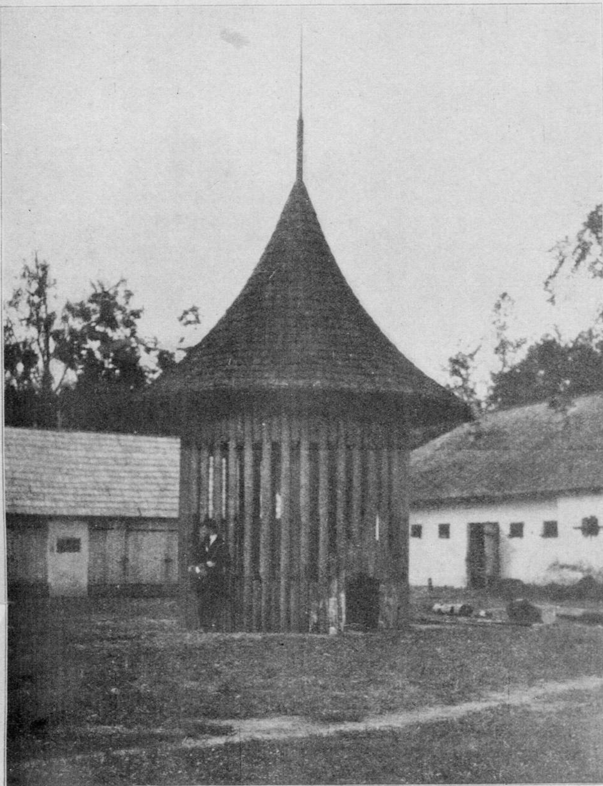
Klatka dla niedźwiedzia w podwórzu pałacu w Postawach
