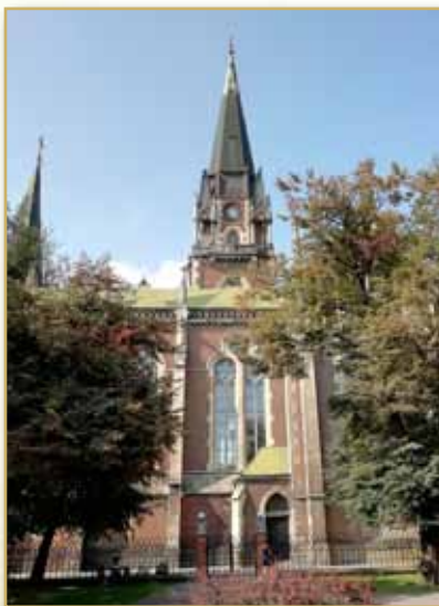
Kościół św. Elżbiety we Lwowie, widok na południową elewację
