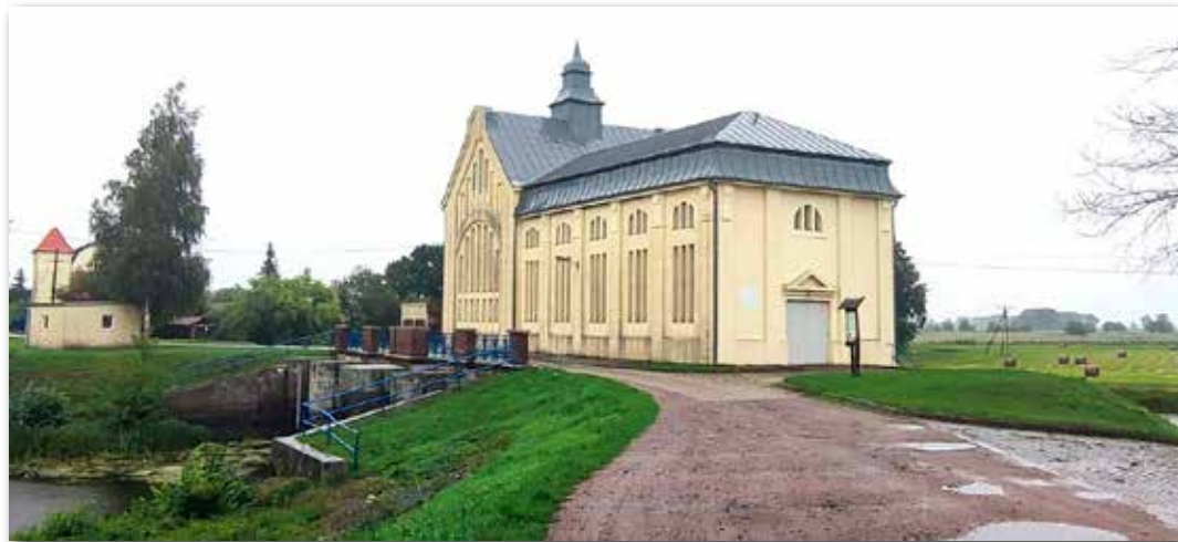
Budynek Stacji Pomp Słońsk, pompownia w Słońsku to nie tylko zabytek techniki, ale także ciekawy architektonicznie budynek powstały w 1910 roku, fot. Jarosław Lalko
