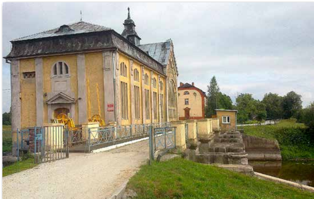
Pompownia Warniki – Kostrzyn nad Odrą, została wzniesiona w 1911 roku, jest bliźniaczo podobna do swojej architektonicznej koleżanki ze Słońska, fot. Marek Ścisły
